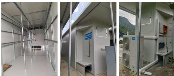
图1 热泵型新建烤烟房及设备安装
